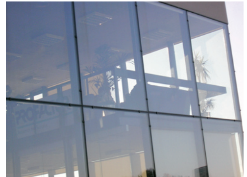
Glasfassade aus Sicherheitsglas
